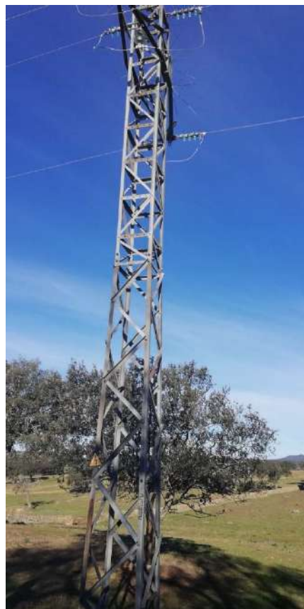
Apoyo 2142 a desmontar
