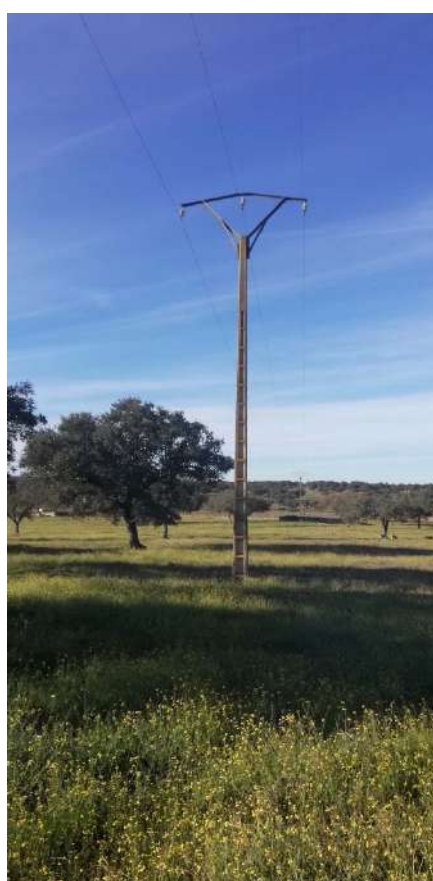
Apoyos de hormigón a desmontar
