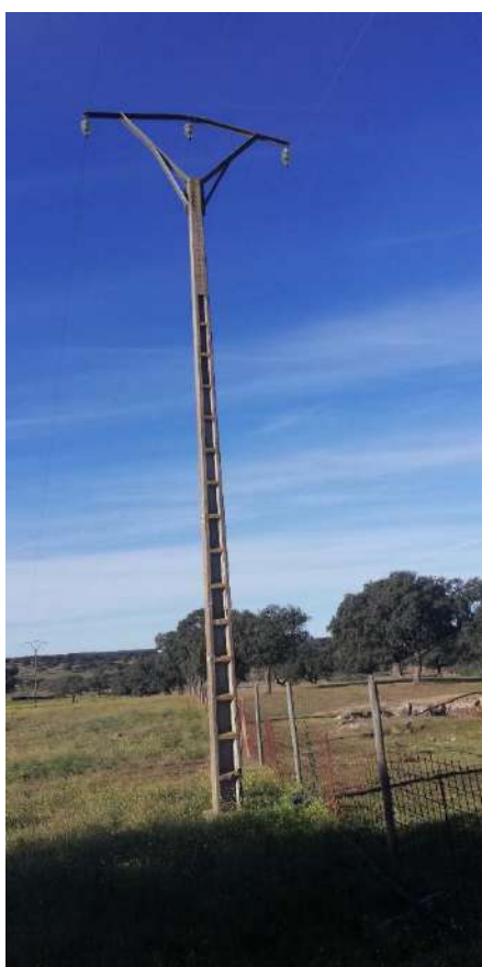
Apoyos de hormigón a desmontar
