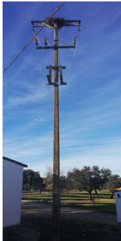
Apoyo a desmontar (antiguo CT "Rosita")
