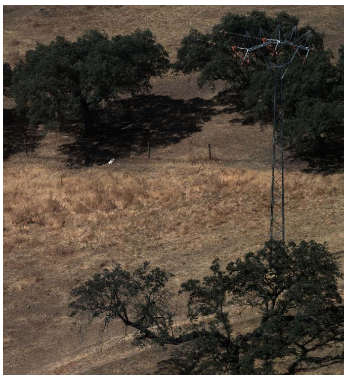
Apoyo 528 de la L-“Cilleros” a sustituir, junto al cual se instalará el nuevo CTIC proyectado
