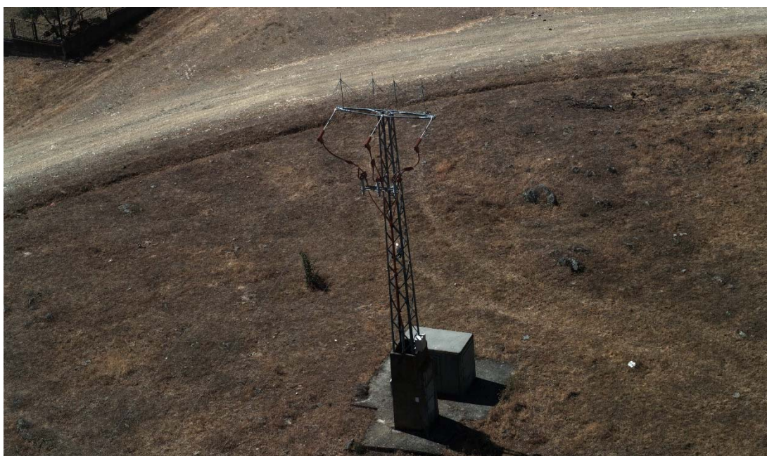
CT “Airtel Moraleja” y apoyo 532 de la L-“Cilleros” a desmontar
