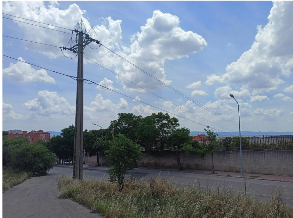
Apoyo 5002 a desmontar
