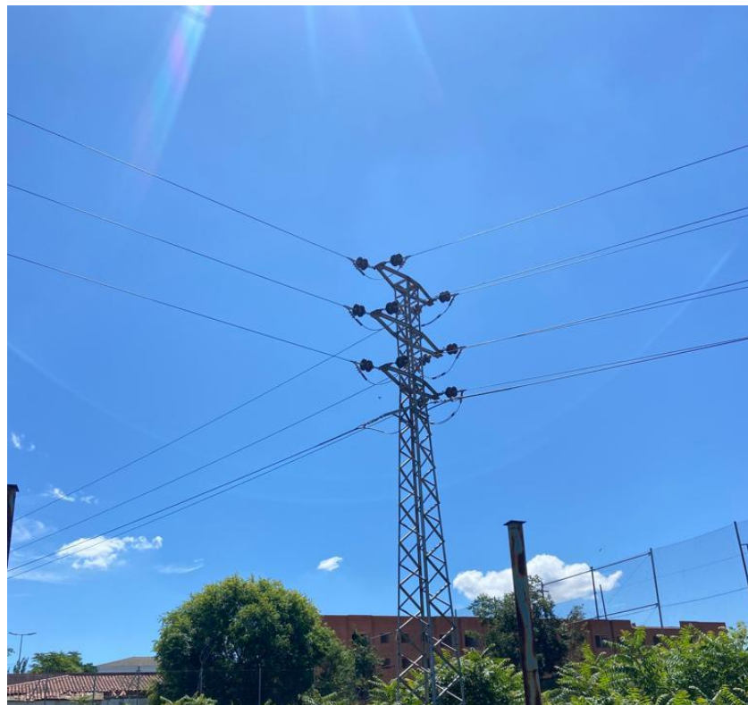
L-“Dehesa” a desmontar, Apoyo 5001 a mantener
