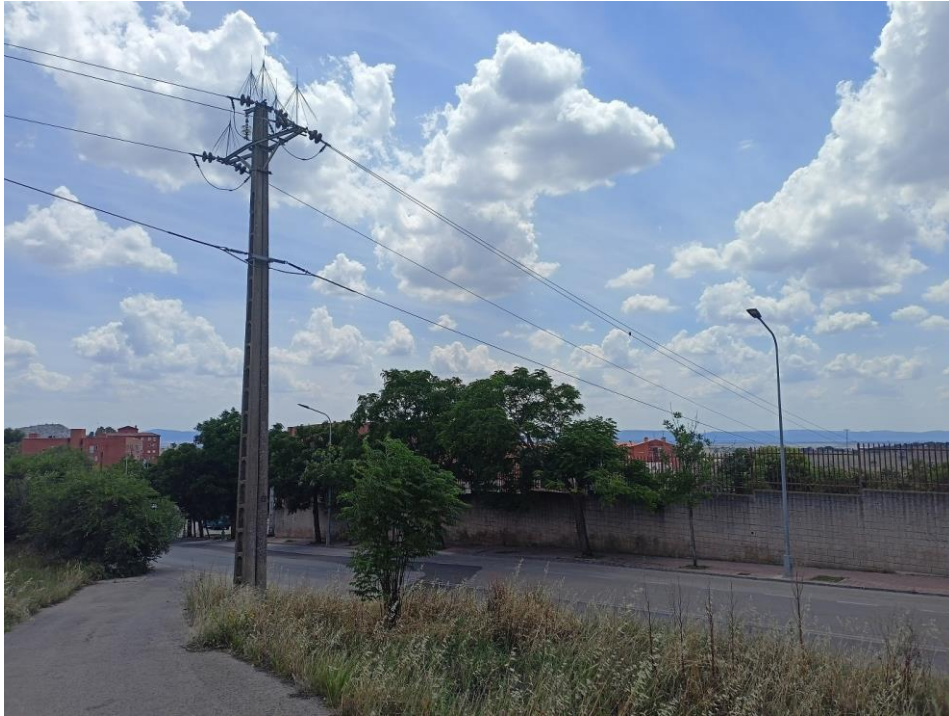
Apoyo 5002 a desmontar
