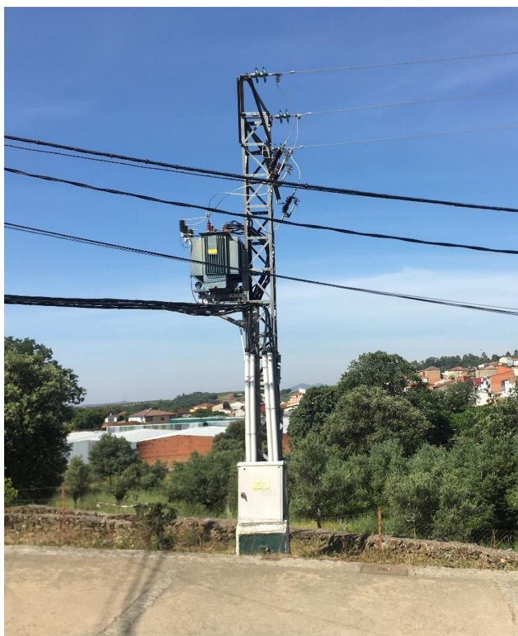
CTIA "Torrecillas Angeles 2" y apoyo 508 a desmontar
