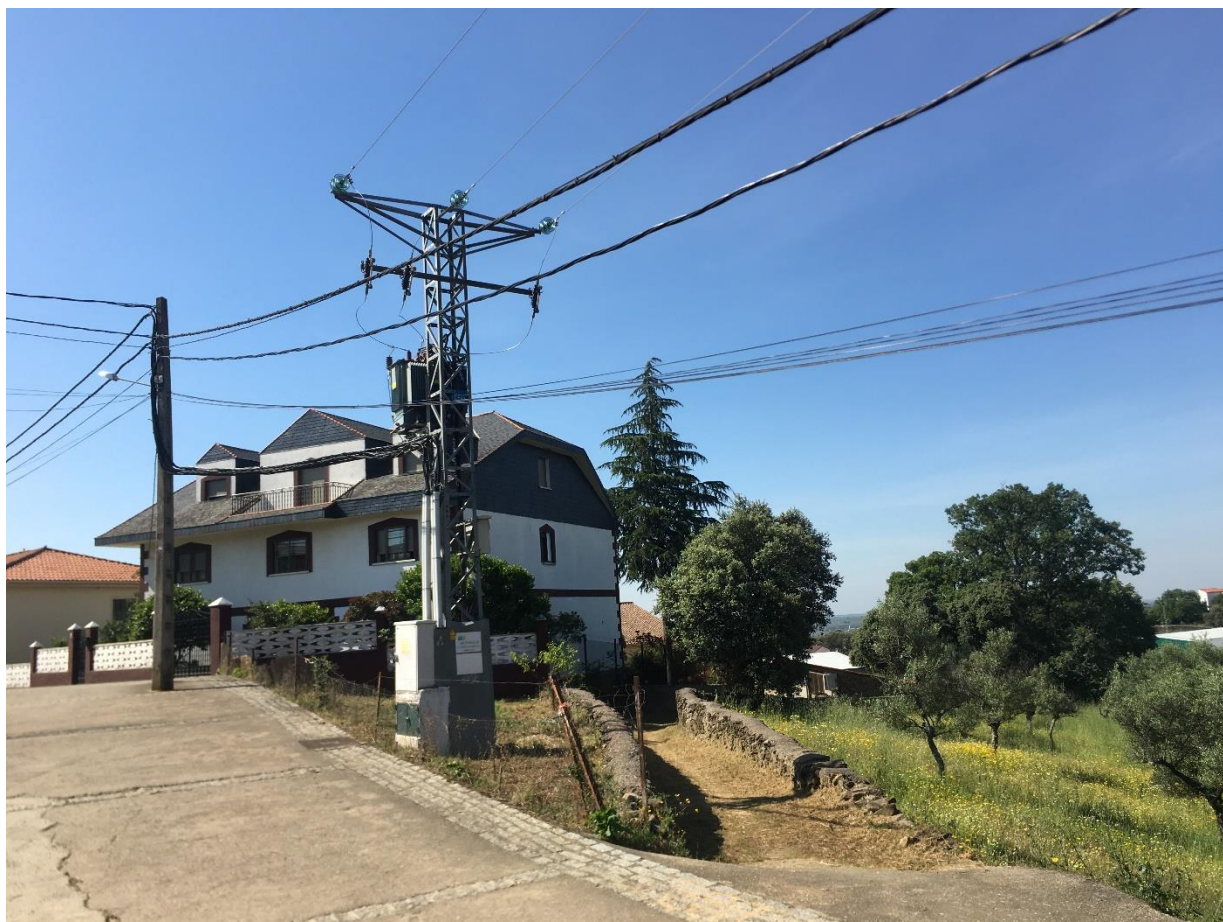
CTIA "Torrecillas Angeles 2" a desmontar y ubicación del nuevo CT
