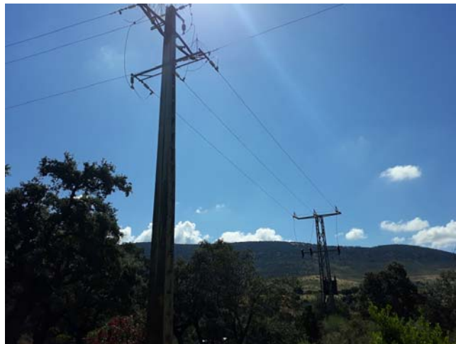
CTIA fuera de servicio a desmontar
