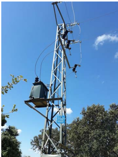
CTIA fuera de servicio a desmontar
