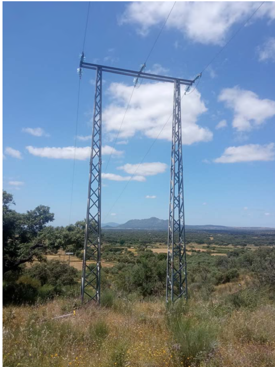
Apoyo 2026 a sustituir y desmontar
