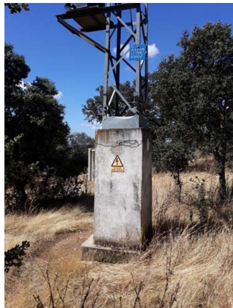
CTIA fuera de servicio a desmontar
