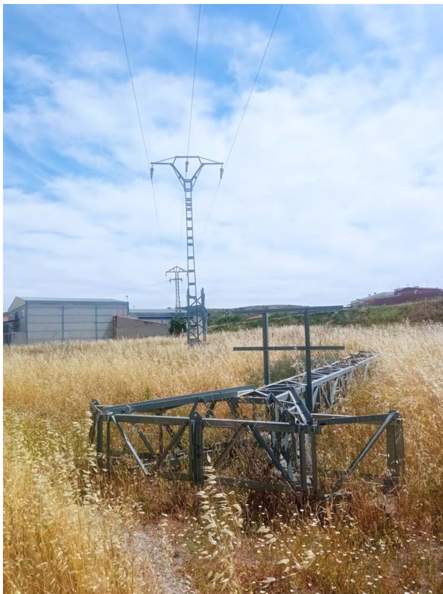
Apoyo 5026 de la L-"Navalmoral-2 " a sustituir y desmontar
