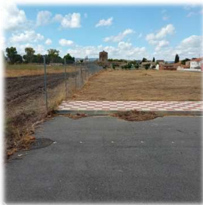
Tramo 1 por calzada de aglomerado asfáltico
