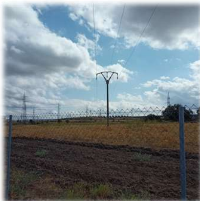
Apoyo de hormigón 5009 (a desmontar)
