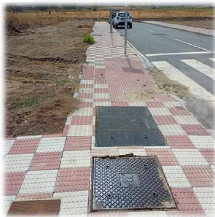
Tramo 2 por canalización existente
