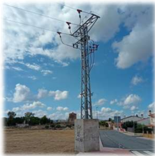
Apoyo 5010 existente a desmontar
