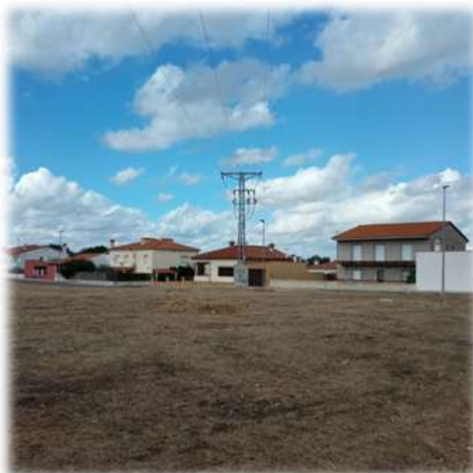
Vano de LANT a desmontar entre nuevo apoyo y apoyo 5010 (a desmontar)
