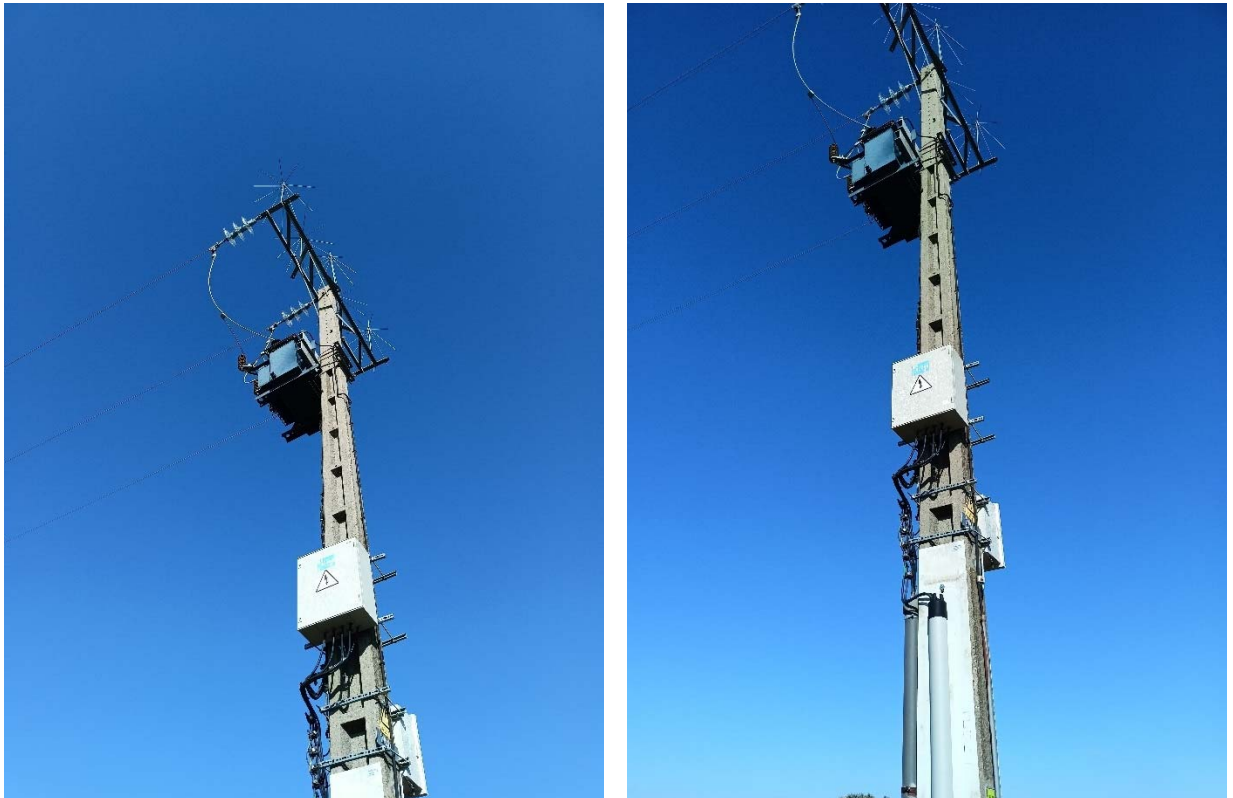
CTIA “Campsa Majón” a sustituir y desmontar
