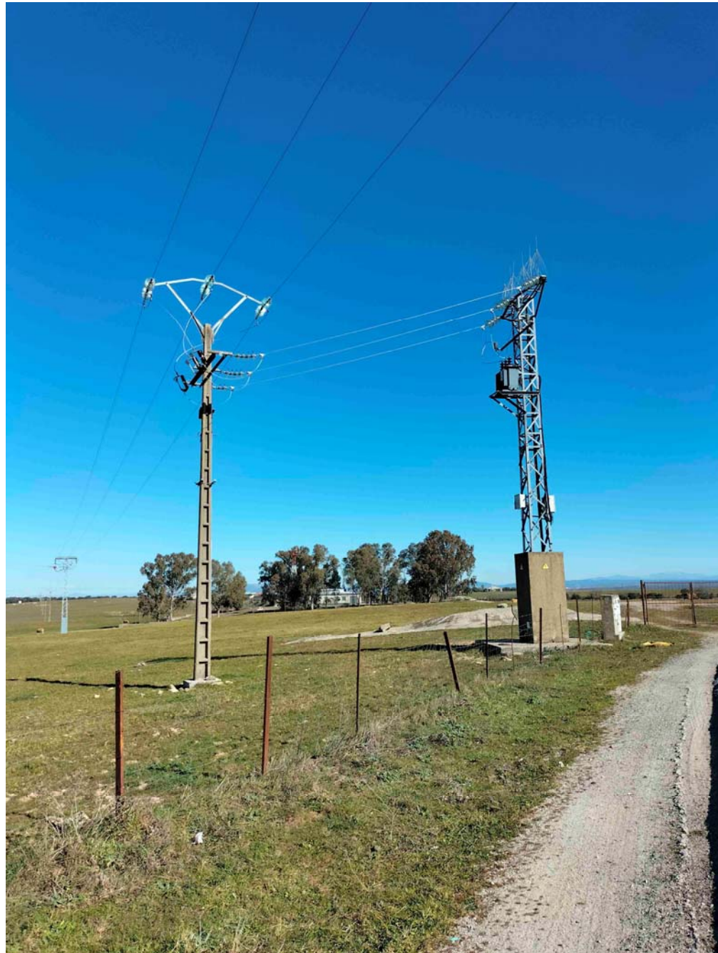
Apoyo 5029 a sustituir y desmontar
