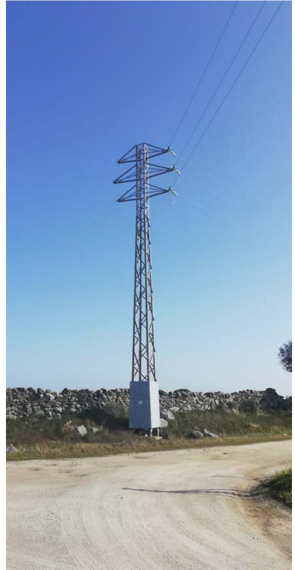
Apoyo 5000 D/C y 5001 donde se realizarán los entronques aéreo-subterráneos
