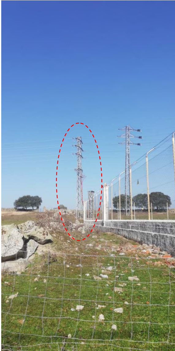
Apoyo 5000 D/C y 5001 donde se realizarán los entronques aéreo-subterráneos
