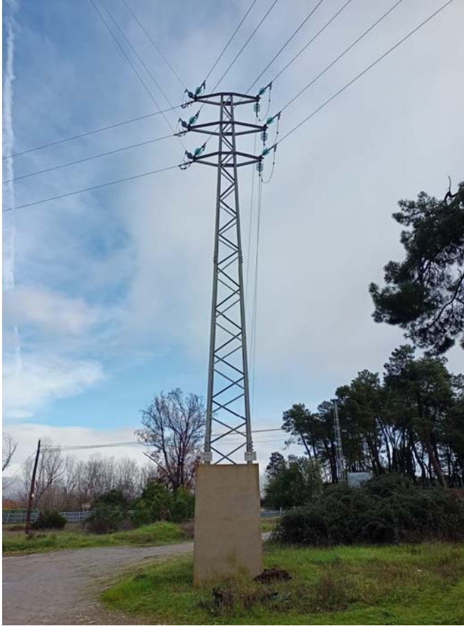
Apoyo 5001 D/C a sustituir y desmontar
