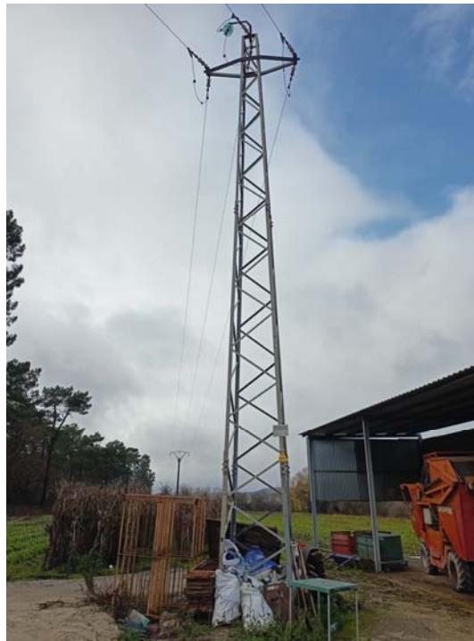
Apoyo 5001 L-“Riegos” a sustituir y desmontar
