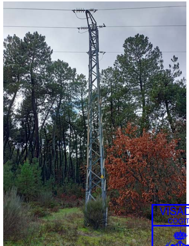
Apoyo 5001 L- "Talayuela" a sustituir y desmontar
