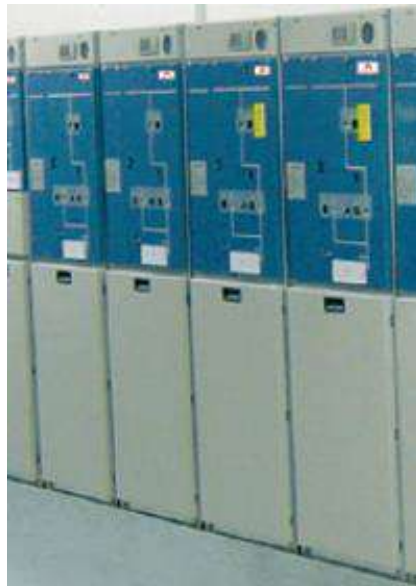
Figura 19.- Ejemplo celdas modulares de MT Schneider
