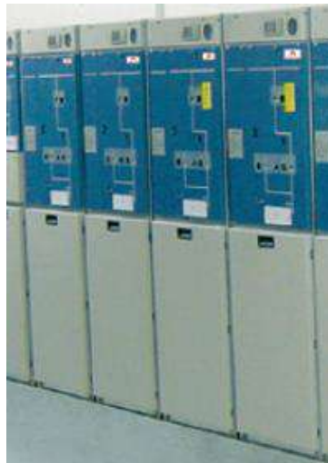
Figura 6.- Ejemplo celdas modulares de MT Schneider
