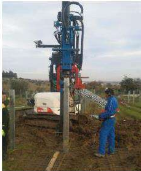
Ilustración 3. Máquina de hincar postes
