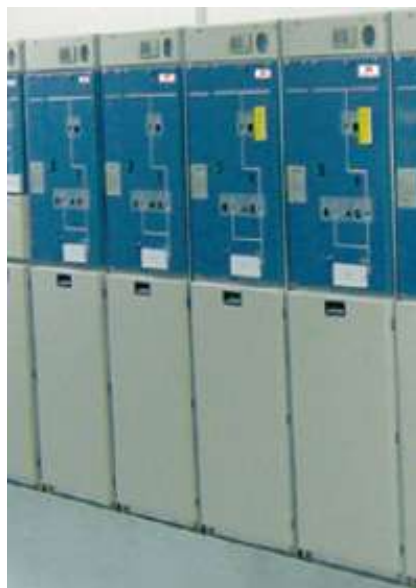
Figura 16.- Ejemplo celdas modulares de MT Schneider
