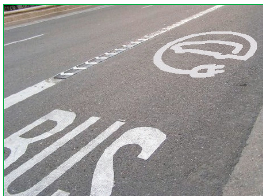
Figura4: Ejemplo de señalización horizontal de carril reservado para vehículos eléctricos compartido con carril bus
